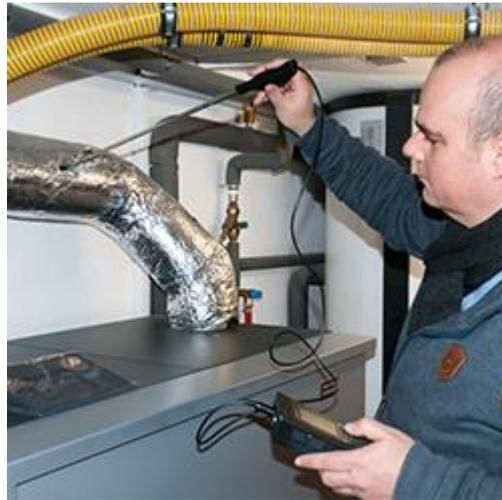
El diseño ergonómico del anemómetro PCE-423 le permite manejarlo con una sola mano
